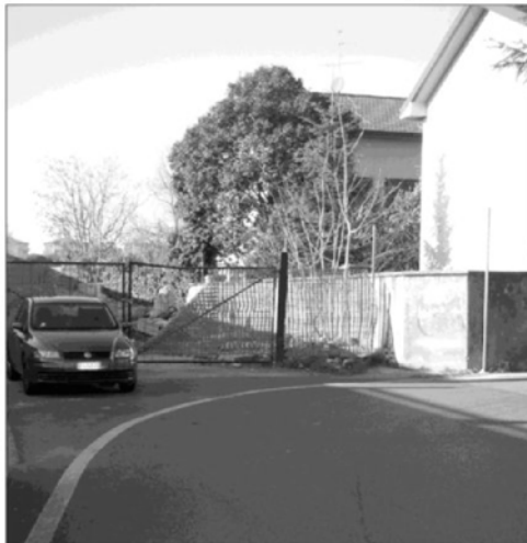
Via Ponchielli Esiste un intoppo di carattere amministrativo, più che tecnico, ad impedire che vengano completati i lavori da parte della Tav (foto Bauermann)
