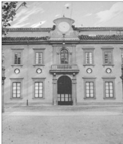
La villa all'interno dell'ex manifattura di Doccia. All'interno dell'ex direzione sarà allocato il polo della cultura
